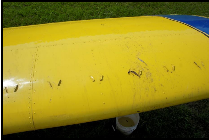
Fotografía No. 9 Otra vista de la fuga de combustible del ala izquierda.
