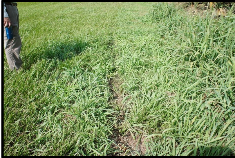
Fotografía No. 15 Marcas de la rodada en la pista, al derrapar la aeronave.
